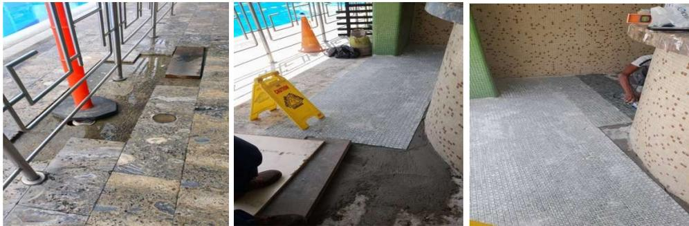
Reparación de rampa ubicada a lado del kiosco, ya que se encontraba muy agrietada y deteriorada.
